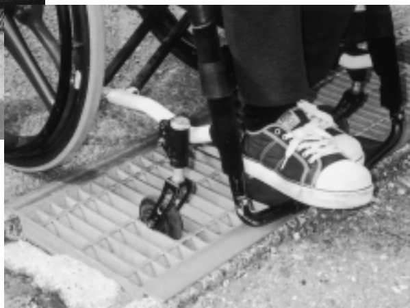
グレーチングの目が粗いと車いす前輪キャスターが挟ってしまう。
